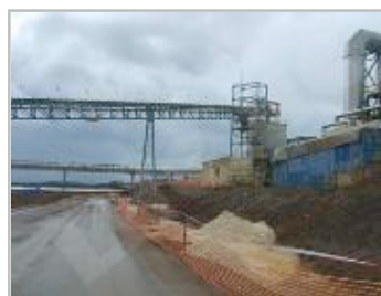
Des barrages de calcaire, visibles en bas à droite sur la photo, ont été mis en place pour neutraliser l'acidité du composant. - Photo DR
